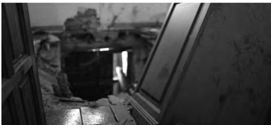
**Foto 2.-** Daños en vivienda: Derrumbe de parte del techo consecuencia de daños causados por termitas subterráneas (*Reticulitermes* sp.). Sevilla. Autor: David Mora
