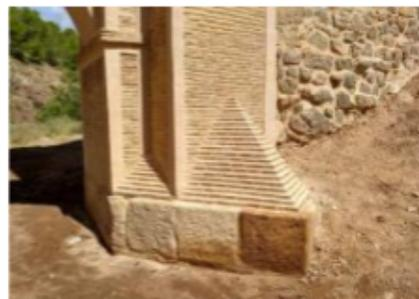
**Figura 12:** La arquería antes y después de la obra. **Figura 13:** Detalle del parteaguas
