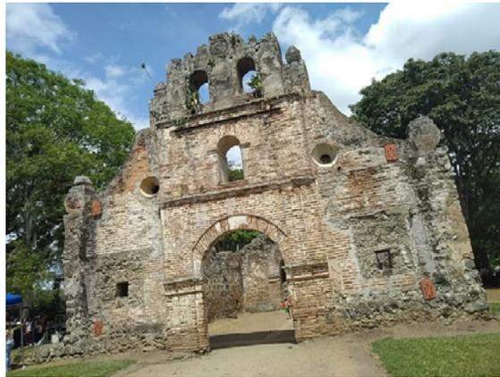
**Figura 3:** vista de las placas estructurales insertadas en la fachada principal de las Ruinas de Ujarrás de una intervención reciente. **Fuente:** elaboración propia.
